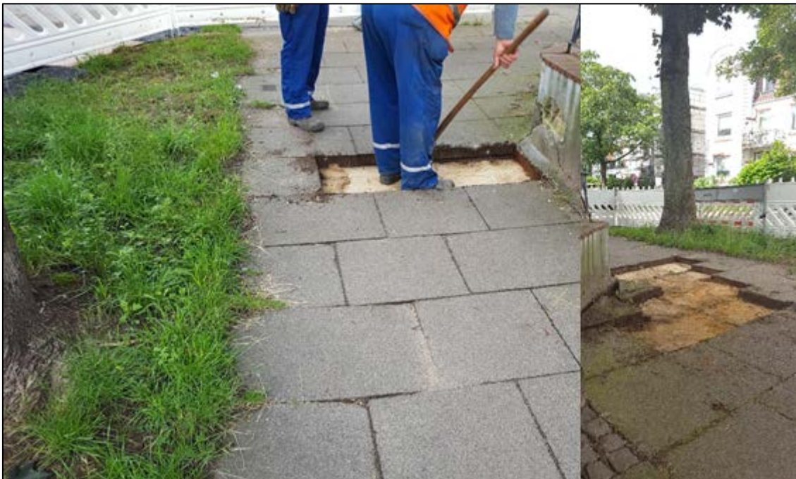
Abbildung 8: Während der anfänglichen Grabarbeiten ist besondere Vorsicht gefragt. Hier entstehen die häufigsten Wurzelschäden durch Grabarbeiten. Baggereinsatz absolut untersagt! Foto: M. Katzer, Baumpflege Bollmann GmbH
