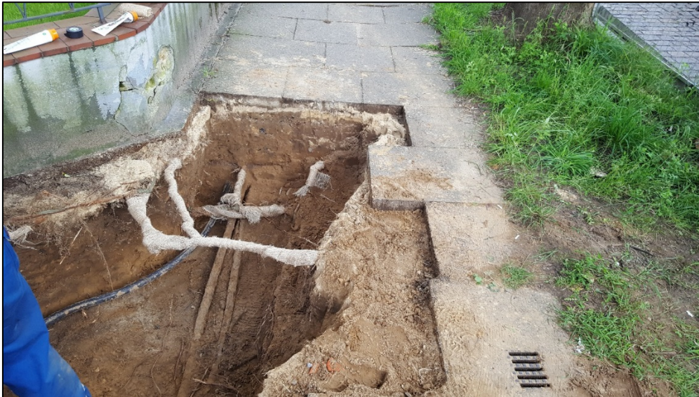
Abbildung 10: Bei diesem Bauvorhaben konnten sämtliche Wurzeln erhalten bleiben. Wurzeln ab 2 cm Durchmesser wurden mit Jute bandagiert. Verletzungen wurden mit wuchsförderndem Mittel behandelt. Foto: M. Katzer, Baumpflege Bollmann GmbH
